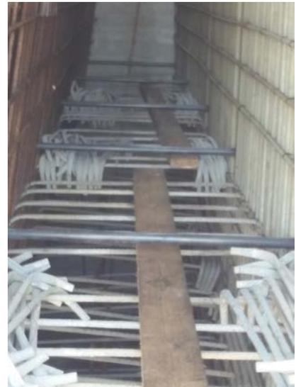
Armado interno del espaldón (en ejecución).
