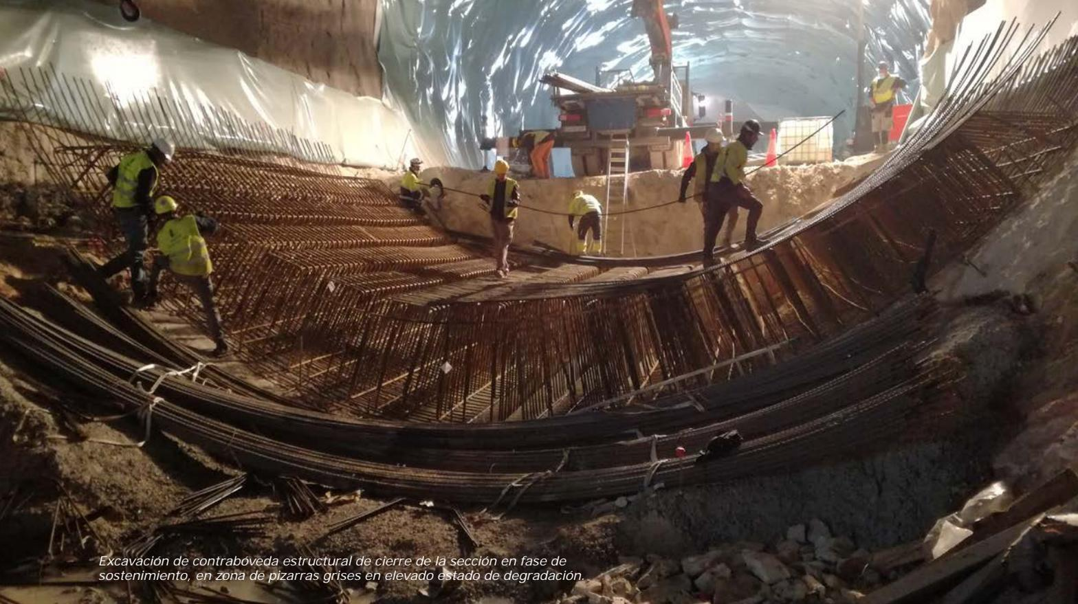
*Excavación de contrabóveda estructural de cierre de la sección en fase de sostenimiento, en zona de pizarras grises en elevado estado de degradación*
