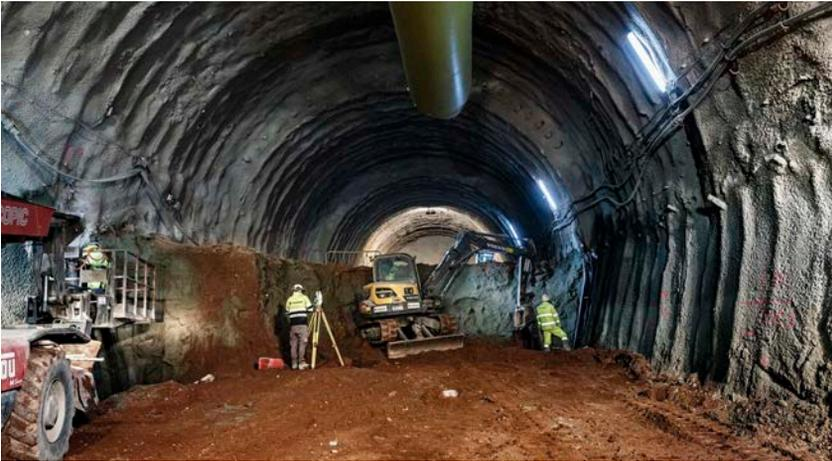
nuevas patologías de inestabilidades y condicionantes geotécnicos del terreno que suponían una afección y un grave peligro para los trabajadores y para la propia obra. Por este motivo, se incorporó al proyecto la ejecución de una contrabóveda estructural de cierre de la sección del túnel en fase de sostenimiento que permitiera el reparto de cargas para frenar las deformaciones que se estaban produciendo, y una nueva sección tipo de sostenimiento en el tramo pendiente de excavar en pizarras.
