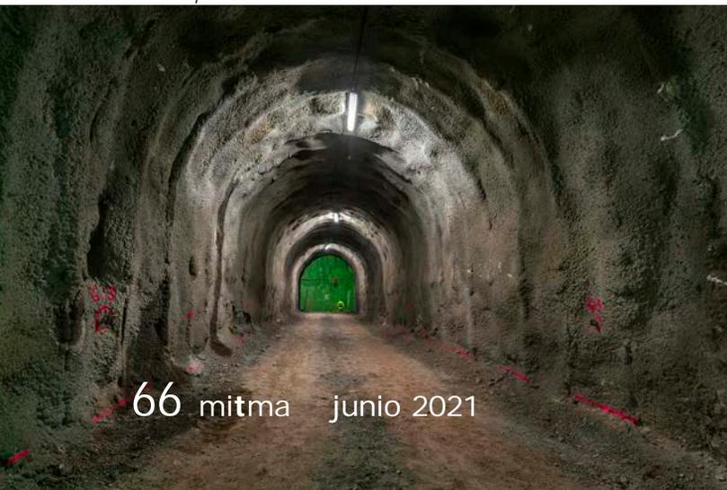
2 aceras de 0,75 m. La sección revestida del túnel es circular de diámetro 11,14 m y su pendiente es del 2,90 % ascendente en sentido Montblanc.
