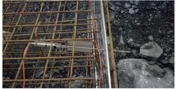
Célula de presión instalada en la contrabóveda de sostenimiento en tramo de pizarras.
