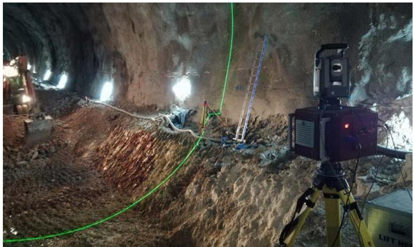
*Reperfilado de la sección con la ayuda del equipo de guiado láser.*
