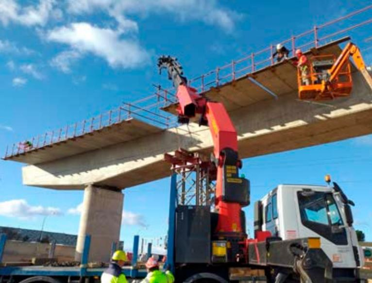
Montaje de prelasas prefabricadas
