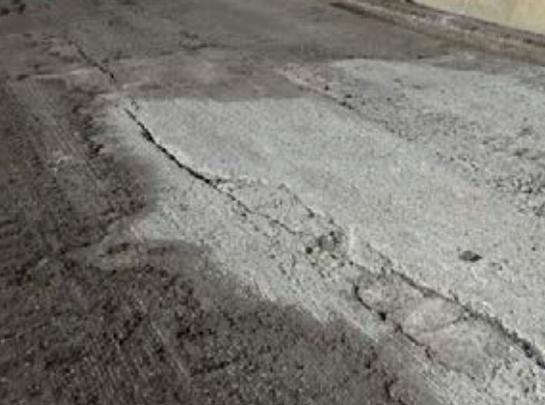
*Fisuración en la cara superior del tablero*
