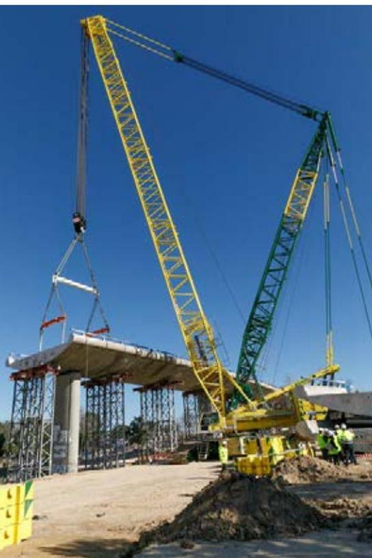
Por ello únicamente se instaló una torre central en la mediana, y se optó por colgar el tablero de unas celosías metálicas situadas sobre éste, que estaban apoyadas en las torres de apeo situadas en los márgenes de la calzada. Las piezas cortadas, de menores dimensiones que el resto de tramos, quedaban suspendidas de esta estructura hasta su descenso y carga en camión para ser transportadas a la zona de picado de las mismas.
