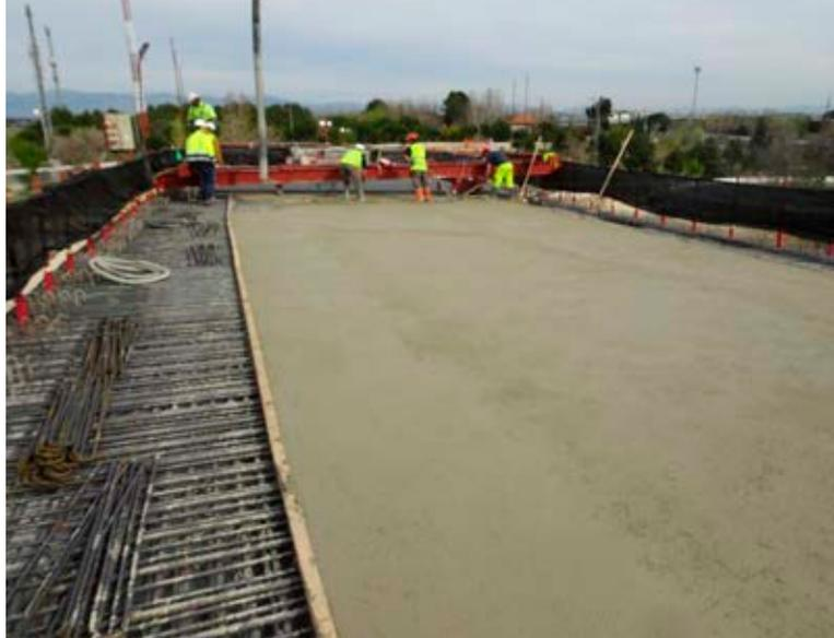
Hormigonado de losa in situ
