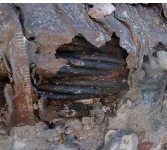
*Corrosión del pretensado*
