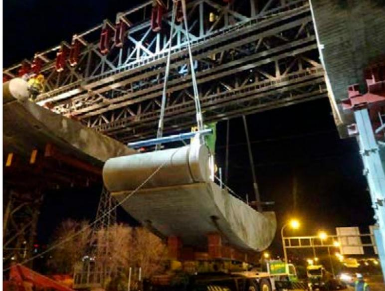
Descenso de secciones en tramo sobre M-40
