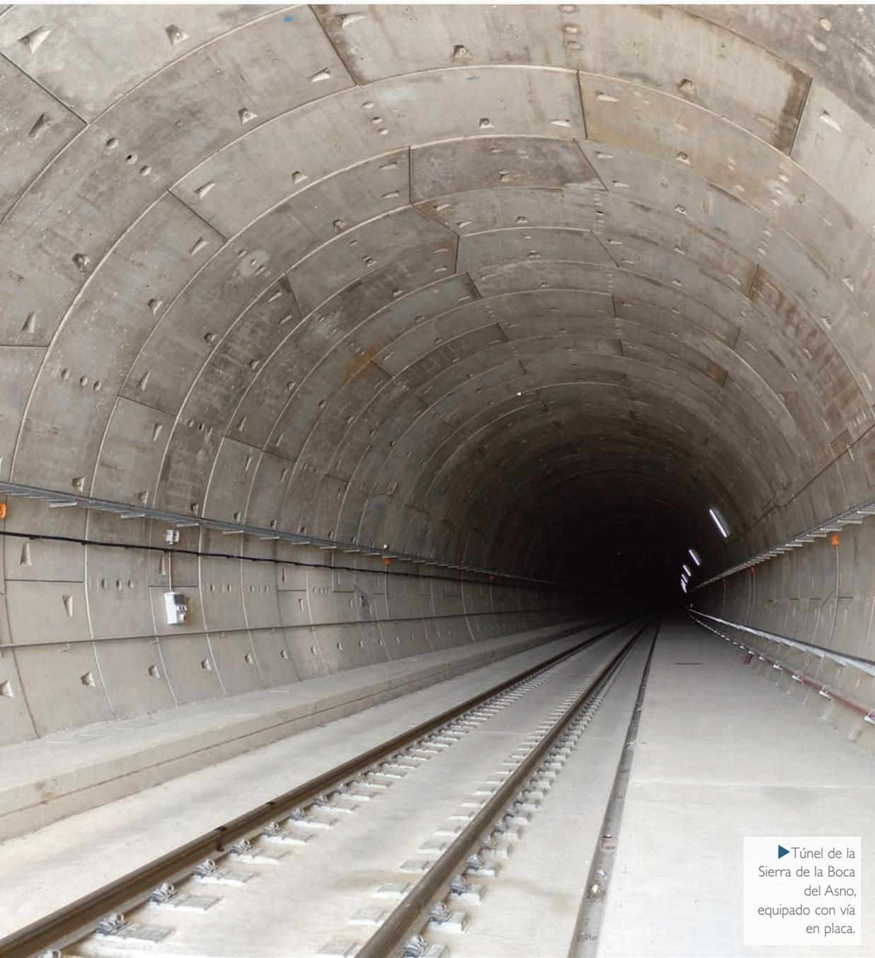
► Túnel de la Sierra de la Boca del Asno, equipado con vía en placa.
