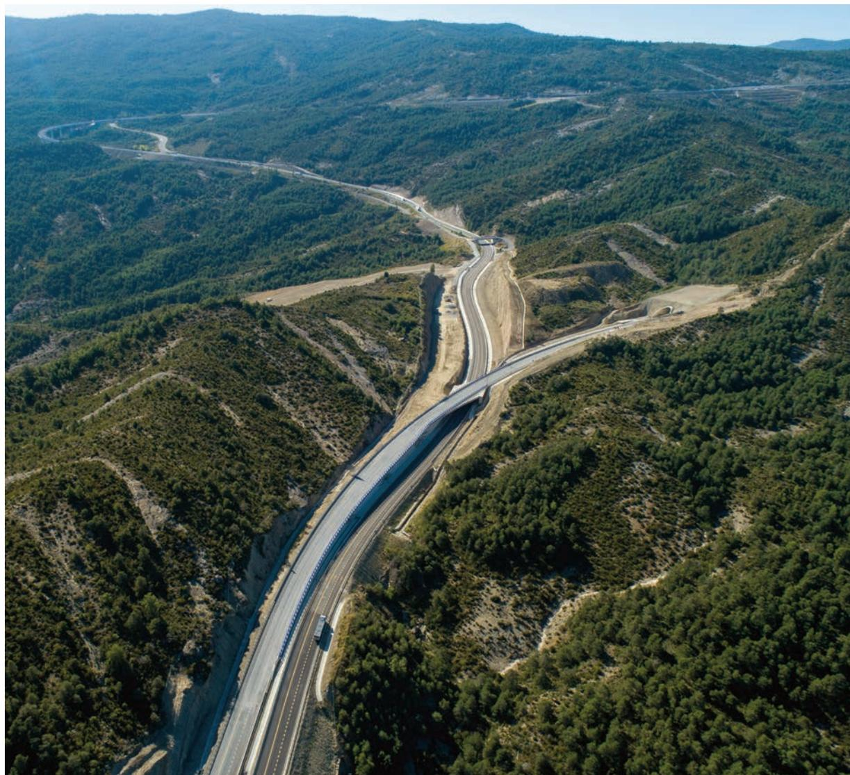
► Cruce de calzadas en el tramo Caldearenas-Lanave: la nueva calzada sentido Jaca atraviesa en el túnel de Escusaguas y la calzada sentido Huesca acondicionada sigue el trazado de la antigua N-330.
