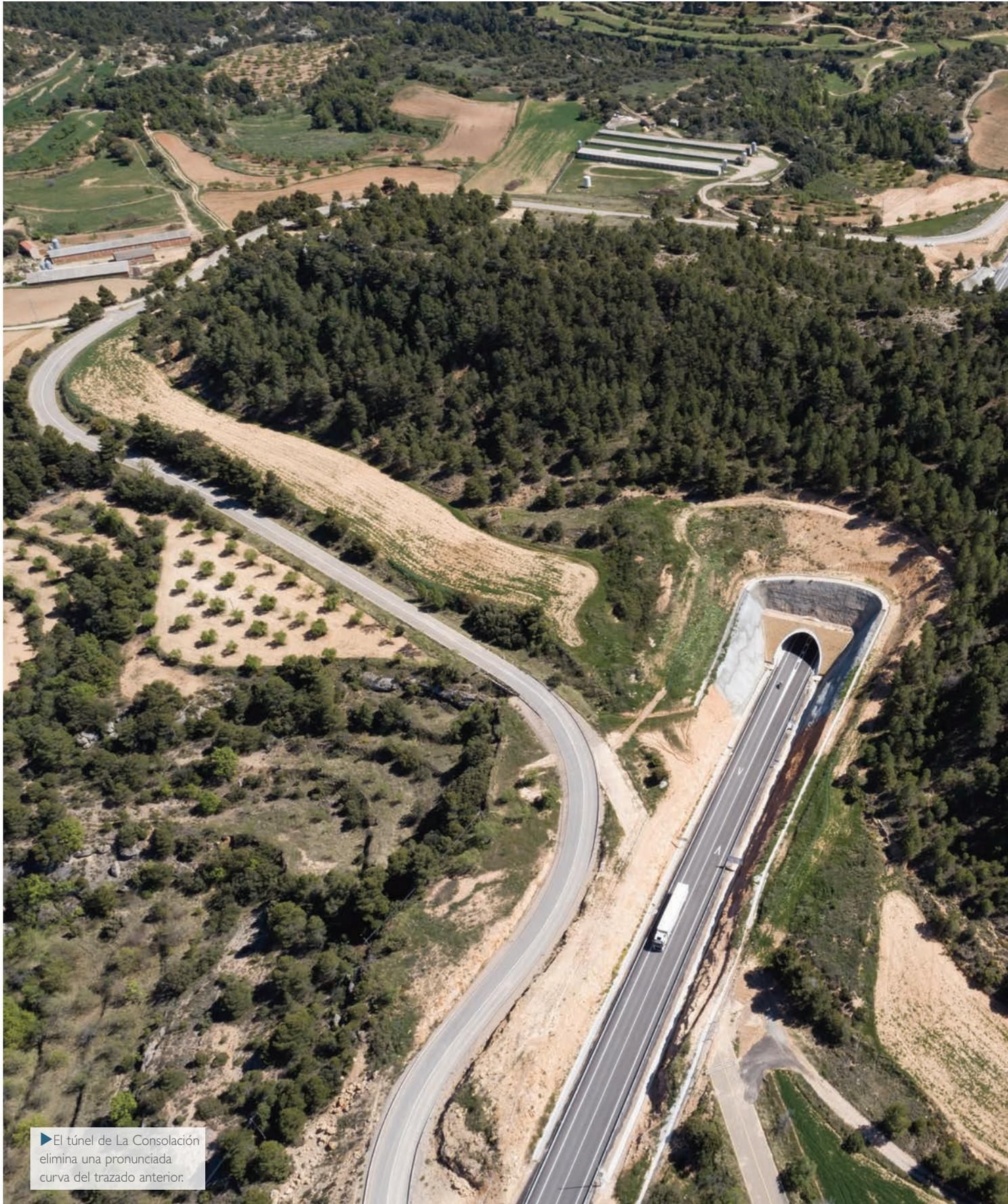
► El túnel de La Consolación elimina una pronunciada curva del trazado anterior.
