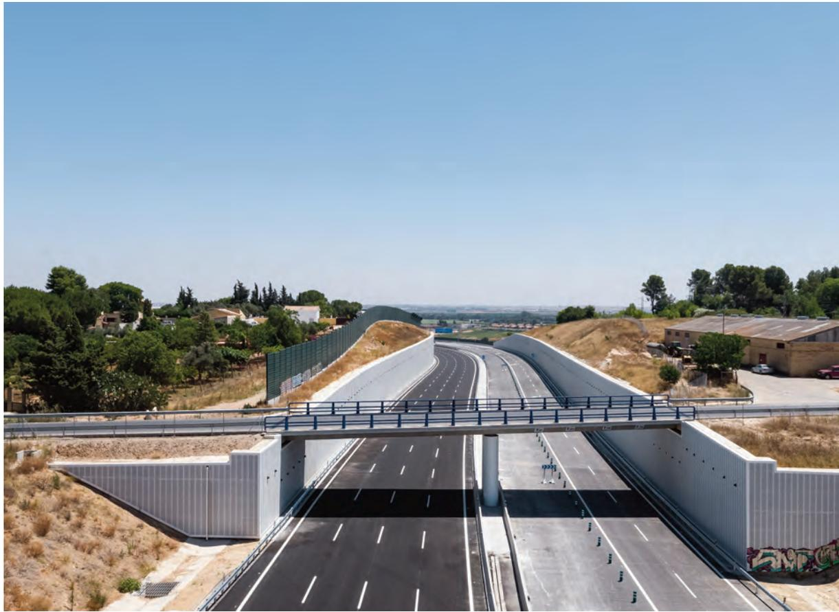
superior a 4 kilómetros y altura máxima de 15,8 metros, así como tres terraplenes, de 970, 150 y 1.500 metros de longitud y altura máxima de 13 metros. Por último, se han construido dos obras de drenaje transversal.
