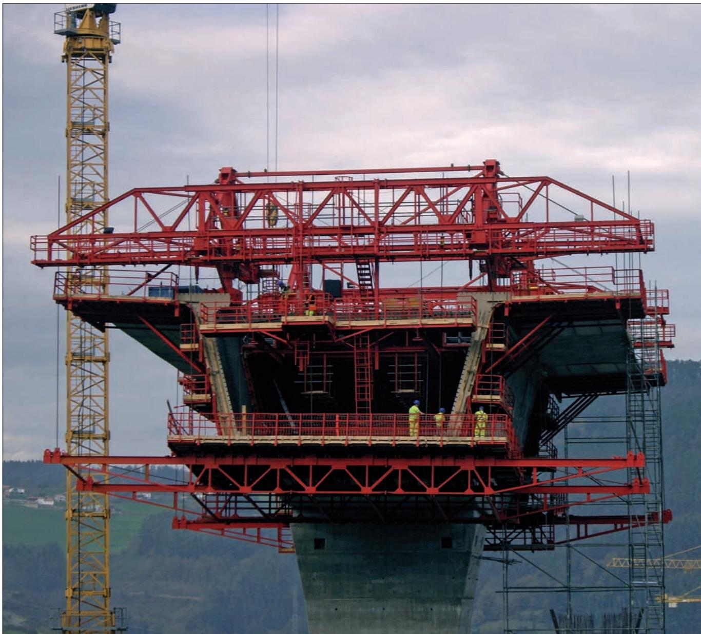
► Los carros de hormigonado incluyen diversas plataformas de trabajo y conexiones entre ellas para acceder a los distintos niveles y trabajos a realizar en estas estructuras.
