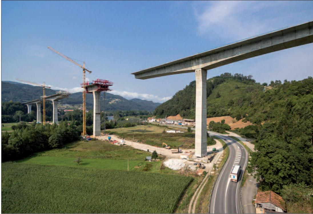
► Detalle de la ejecución de voladizos del viaducto. Bajo la estructura discurre la carretera autonómica AS-15.
