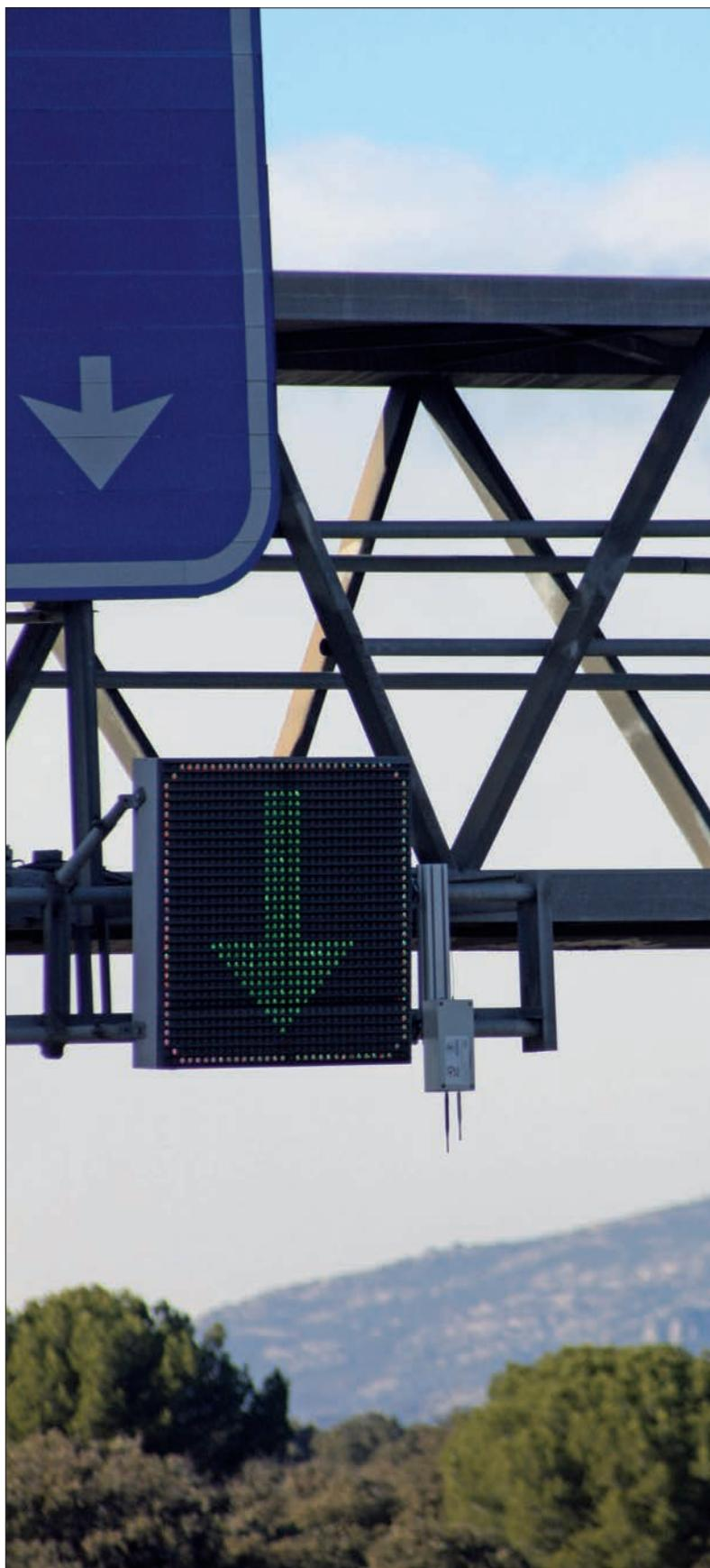
▶ Antena del tipo road side unit instalada en una autovía de acceso a Madrid.
