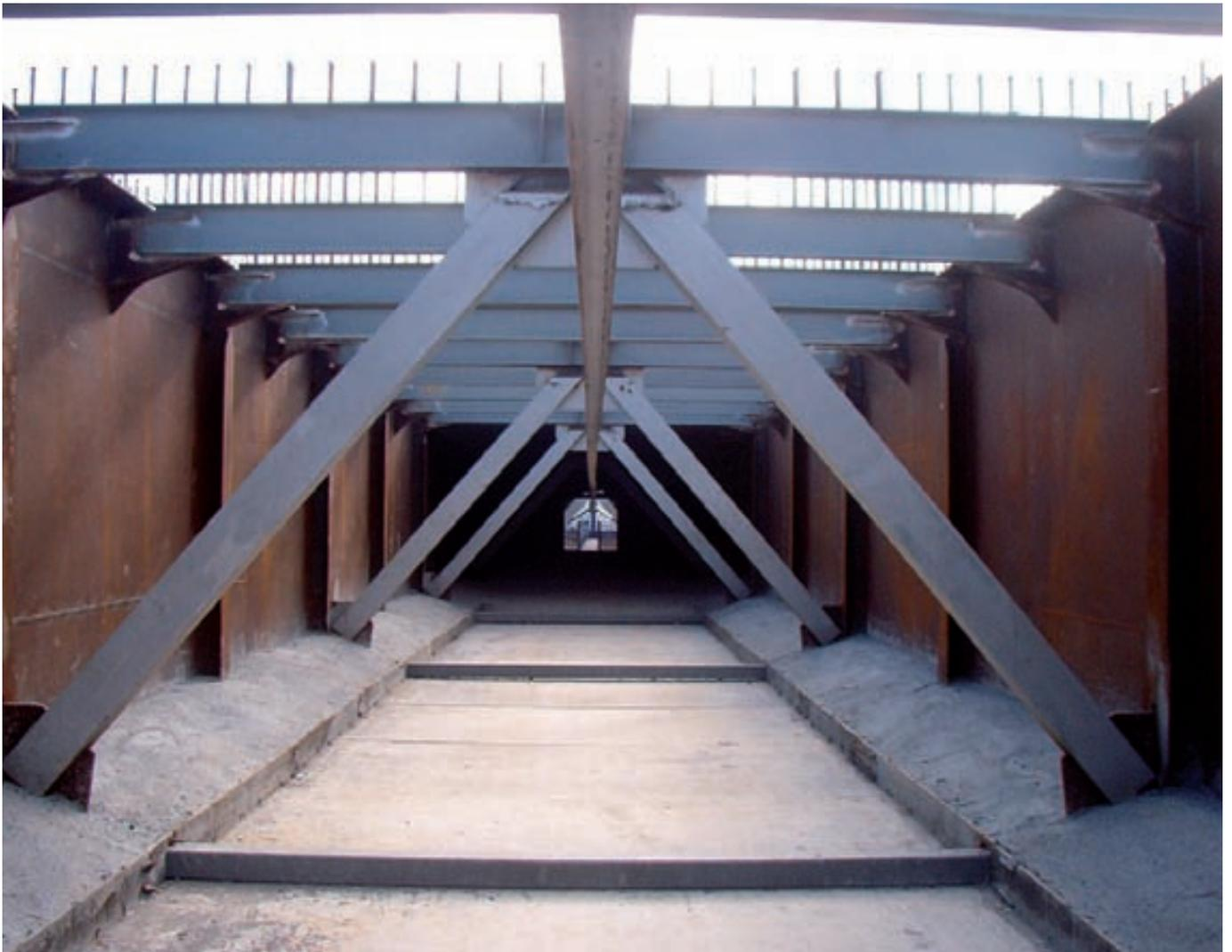
► *Dovela ya hormigonada en el fondo y abajo, preparación de una viga metálica.*
