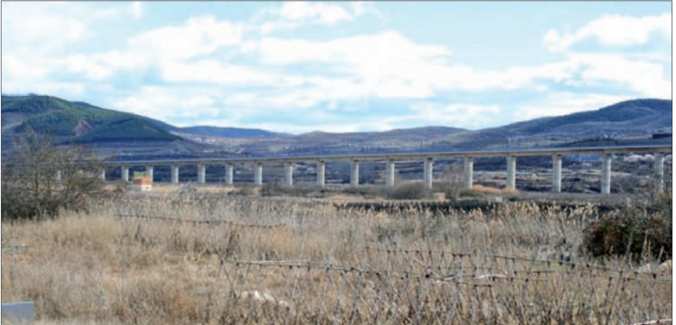
En el tercer tramo y segundo hiperestático, de la pila 54 a la 58, sobresale ésta última al recoger todas las fuerzas horizontales de 165 m de viaducto. El último tramo y segundo isostático, se resolvió al asumir cada pila las fuerzas horizontales de un vano.
