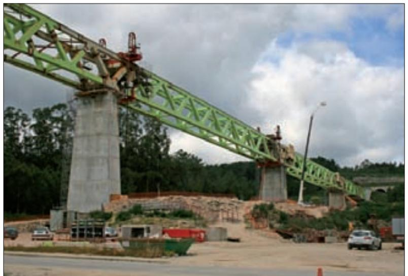
posteriormente se lanzaron los vanos 3 y 4 desde la P-3 hasta la P-4 (120 m). La fase III consistió en el izado mediante grúas de las dovelas del tramo comprendido entre la pila 2 y el estribo 1, con lo que concluyó este tramo de canto constante.
