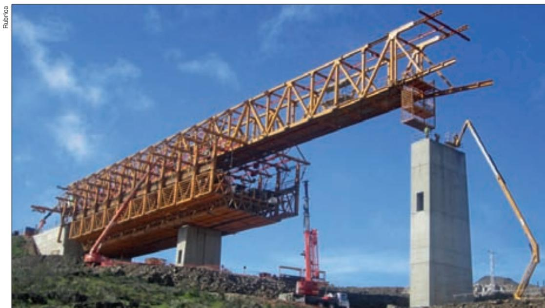
► Arranque de los pies del arco con los carros de encofrado ejecutando las primeras dovelas. Debajo, avance del tablero desde el estribo.
