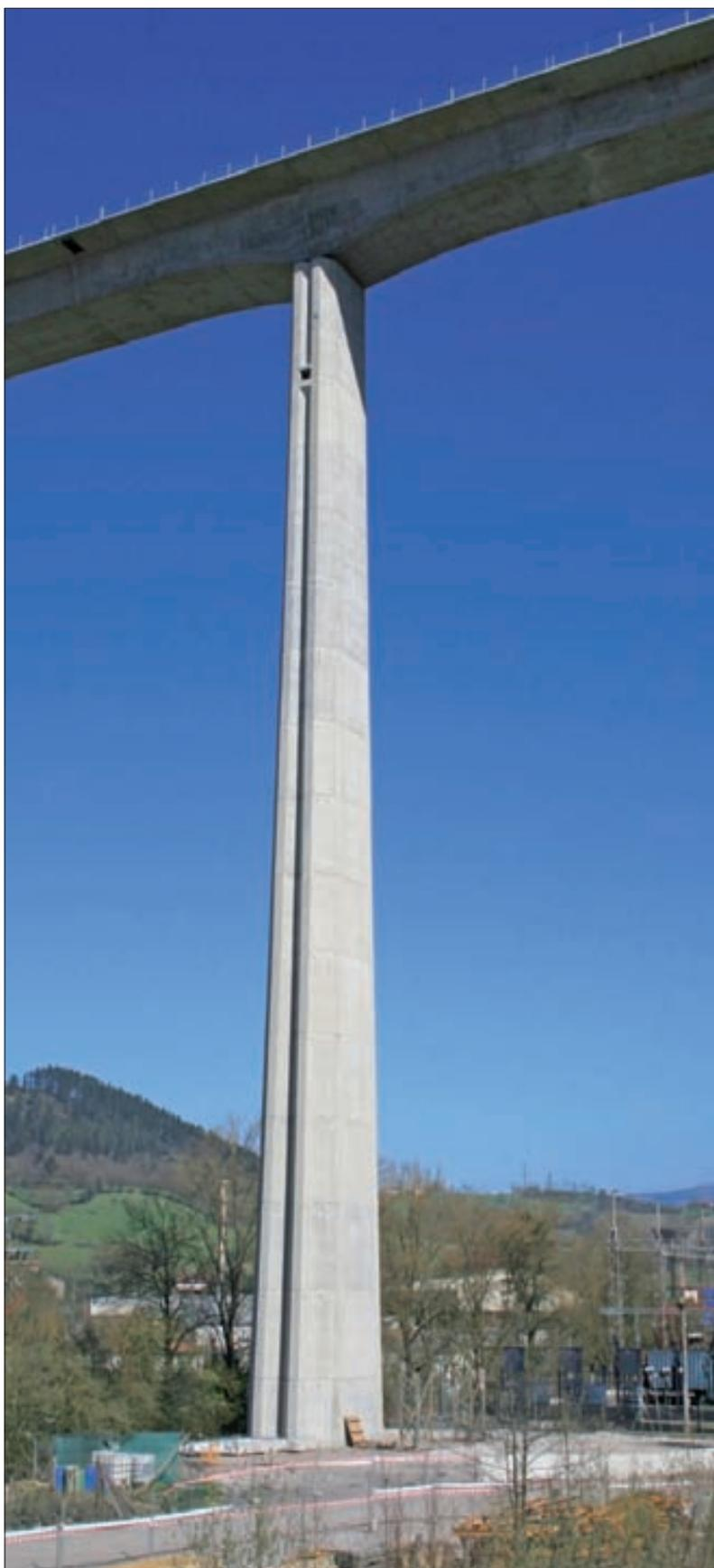
de mantener siempre constante la geometría en los moldes de encofrados variables, independientemente de la luz del vano, manteniendo el canto constante en una gran zona intermedia del centro del vano (un 53% en los vanos de 65 m y un 62% en el vano de 80 m), lo cual le confiere una sensación de esbeltez al tablero.
