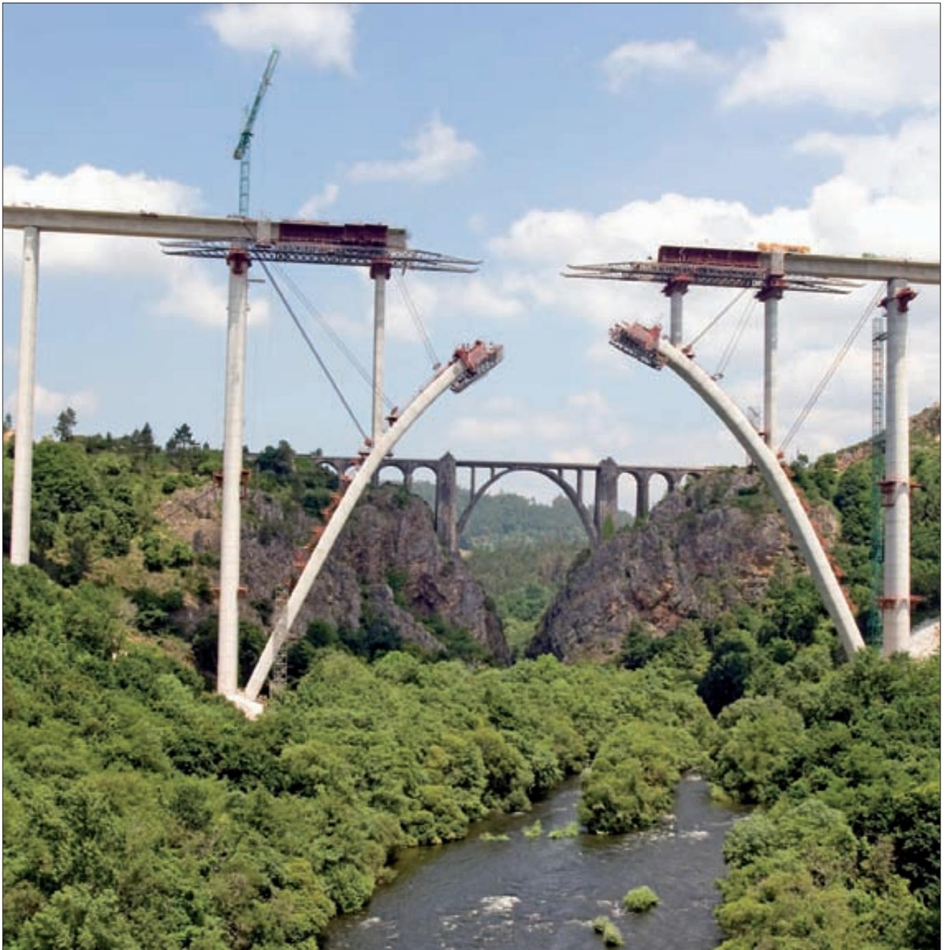
Entre los elementos más singulares del viaducto destaca muy especialmente su gran arco central peraltado, de 168 m de luz y 105 m de flecha. Es de sección cajón constante, de 7,70 m de ancho y 3,50 m de canto. Su construcción se realizó mediante cimbra en los tramos iniciales de los semiarcos, en los que se instalaron sendos carros de avance para la ejecución de dovelas “in situ”. Para el avance hasta las cotas del cierre en clave se utilizó un sistema de atirantado provisional
