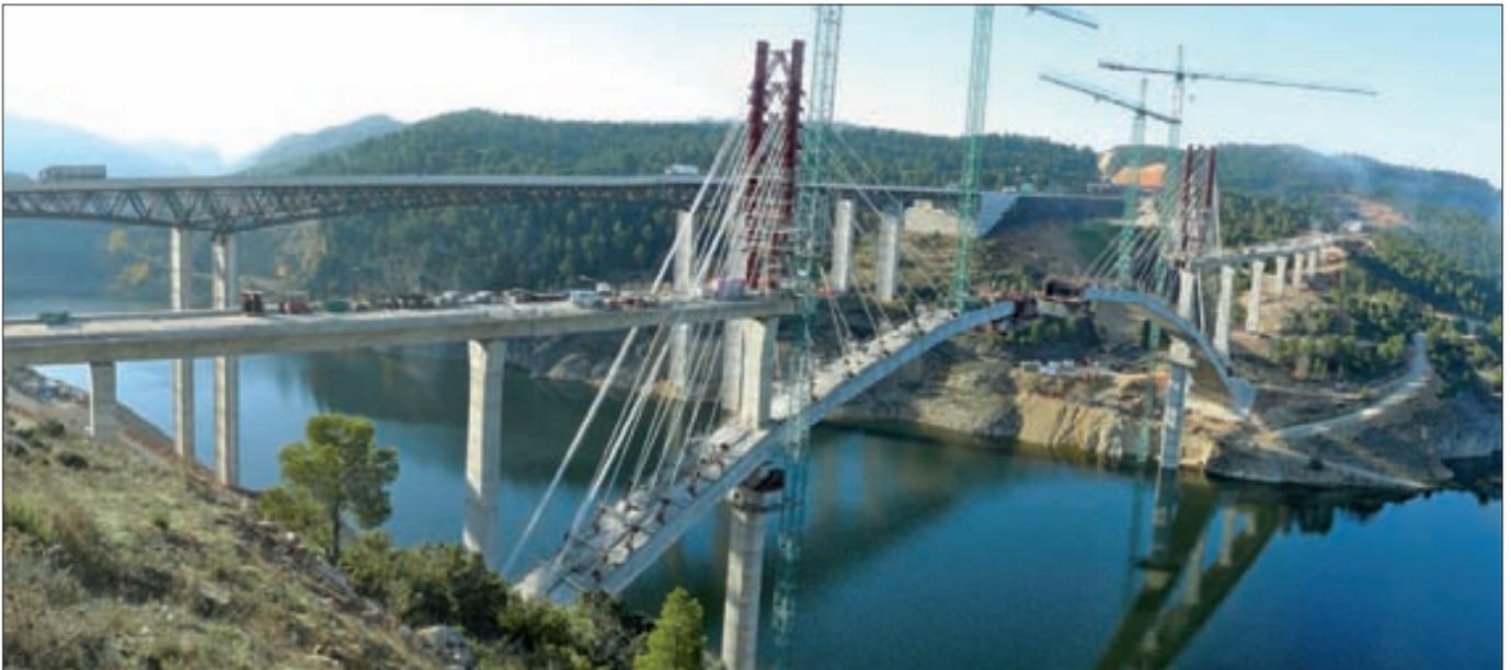
► *La ejecución del arco y tablero avanza simultáneamente.*
