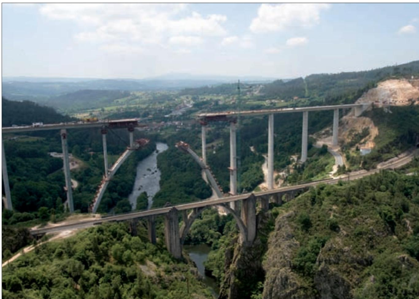
lastras que descansan sobre el arco de 168 m de luz que salva el río Ulla. El arco central tiene una altura de 104,4 m y se realizó mediante el empleo de dos carros de avance en voladizo, uno para cada semiarco. Éstos tienen una longitud de 10,2 m y se unen mediante una dovela de clave. Esta infraestructura cuenta con un total de 26 dovelas de 5 m.
