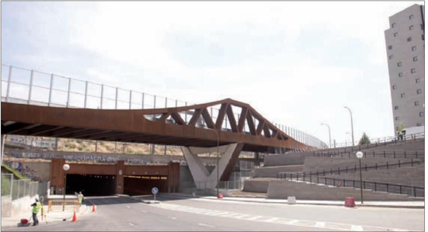
La adecuación de la catenaria de la línea C-5 para lograr el gálibo adecuado sobre la misma fue una de las operaciones más complicadas. La dificultad añadida de la localización del viaducto requirió en su diseño incorporar un canto resistente por encima de la cota de la plataforma para lograr que la estructura pasase sobre la calle del Comercio con ese gálibo necesario, que tenía que ser mayor de 10,2 m, y con una altura sobre la línea de Cercanías C-5 de más de 6,3 m.
