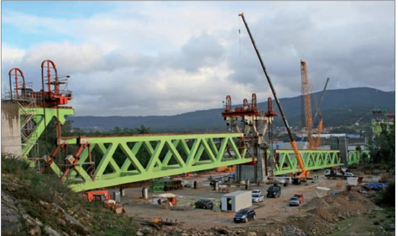
► En la página opuesta, avance en voladizo del tablero. Arriba, izado de dovelas en una de las secciones del viaducto.
