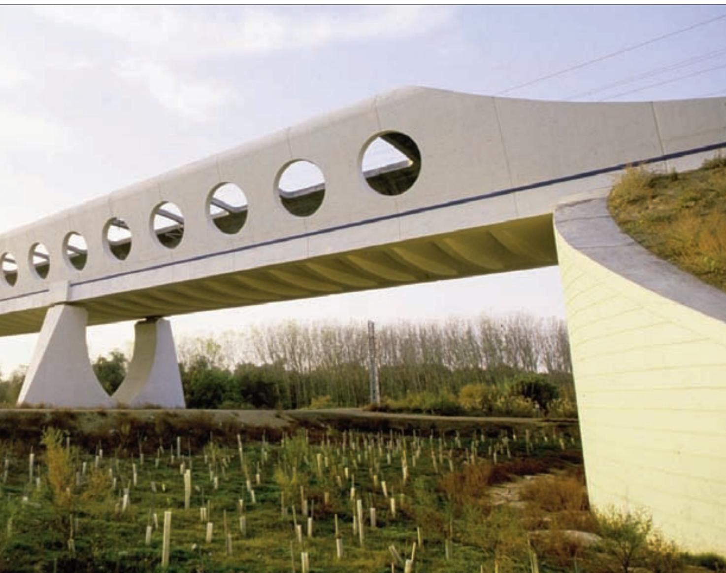
*Todo el control del empuje se efectuó desde una sola central hidráulica*
