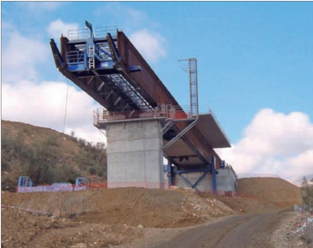
► Empuje del tablero desde uno de los estribos. Debajo, viga sometida a pruebas de control de rigidez.
