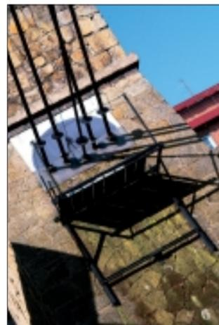
*Detalles de las torres metálicas y del tendido de cables de acero que rigidiza el puente.*
