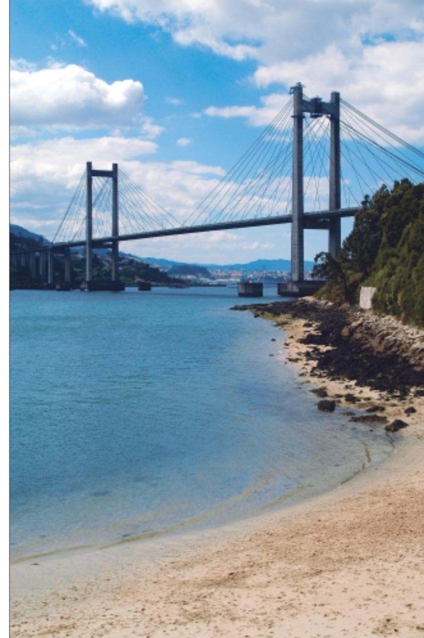
Los elementos fabricados se trasladaron por ferrocarril y barcaza hasta el puente y el montaje del tablero se efectuó por voladizos sucesivos desde las dos pilas hasta 147'42 metros, simétricamente respecto a cada pila; y de este punto hasta el centro del vano, compensado por amarre en las pilas laterales. Para ello se utilizó una plataforma auxiliar de montaje tipo celosía en cada zona de avance, suspendida del tramo ya colocado, el cual, a su vez, va suspendido de los cables.
