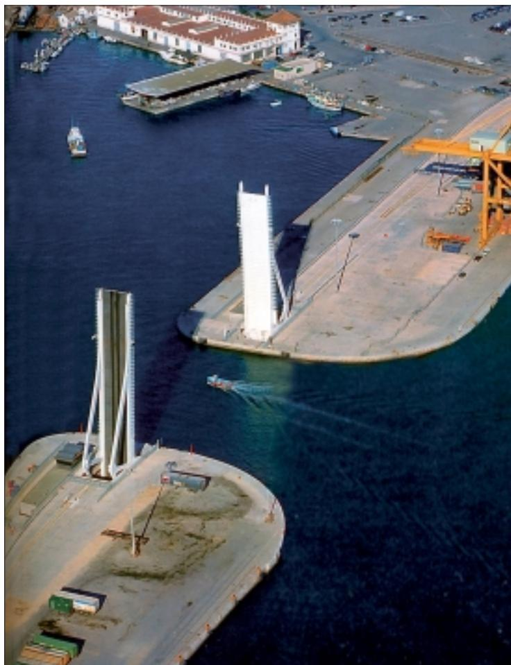
Hasta 48 horas de maniobras y trabajos se invirtieron en la colocación definitiva de los tableros del puente. Una vez lanzado y descendido cada uno de los semitableros, se procedió a anclar las bases de las rótulas de giro a su cimentación, se conectaron las tuberías hidráulicas de cada tablero a las instaladas en los fosos y, por fin, se realizó la primera prueba del puente. ■
