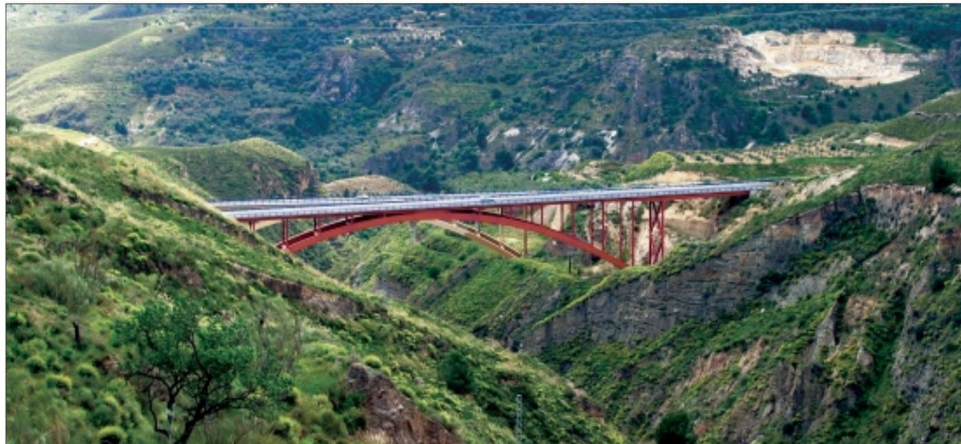
ras del barranco. Los arcos tienen geometrías parabólicas con flecha central de 25 metros. Cada arco está constituido por un cajón rectangular de 2 metros de canto y 1,20 m. de ancho, con diafragmas y rigidizadores interiores. Transversalmente, los arcos van unidos por vigas al cajón de sección rectangular, conformando una estructura tipo Viendeel que asegura su estabilidad transversal frente a las acciones del tráfico y el sismo”.
