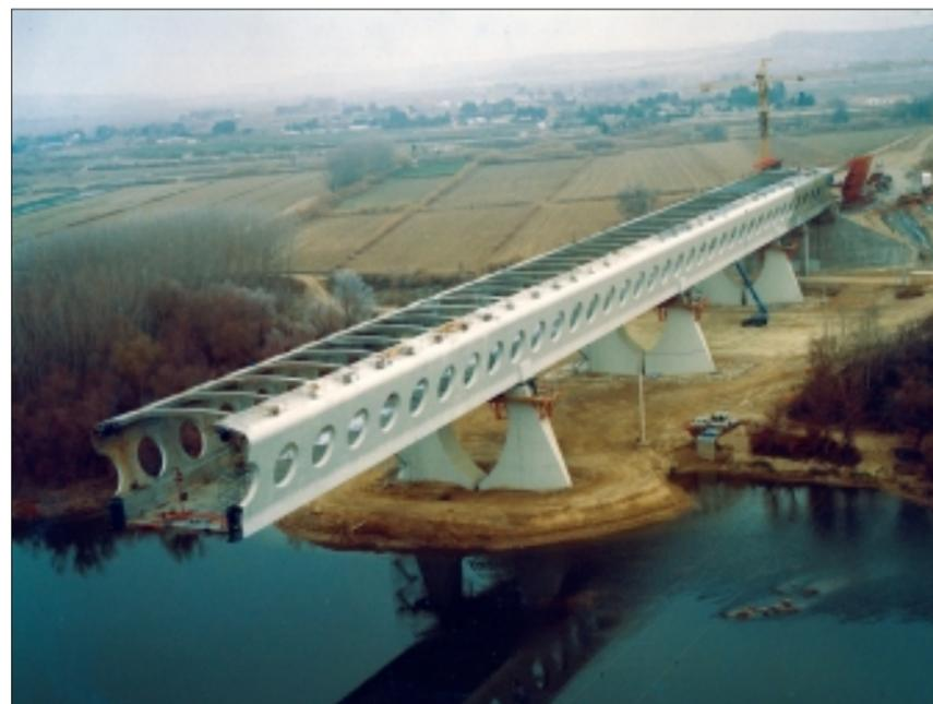
120 metros de luz –el mayor de España en puentes de ferrocarril-, tres de 60, 60 y 42 metros en la margen izquierda, y otros dos de 60 y 42 metros en la derecha.
