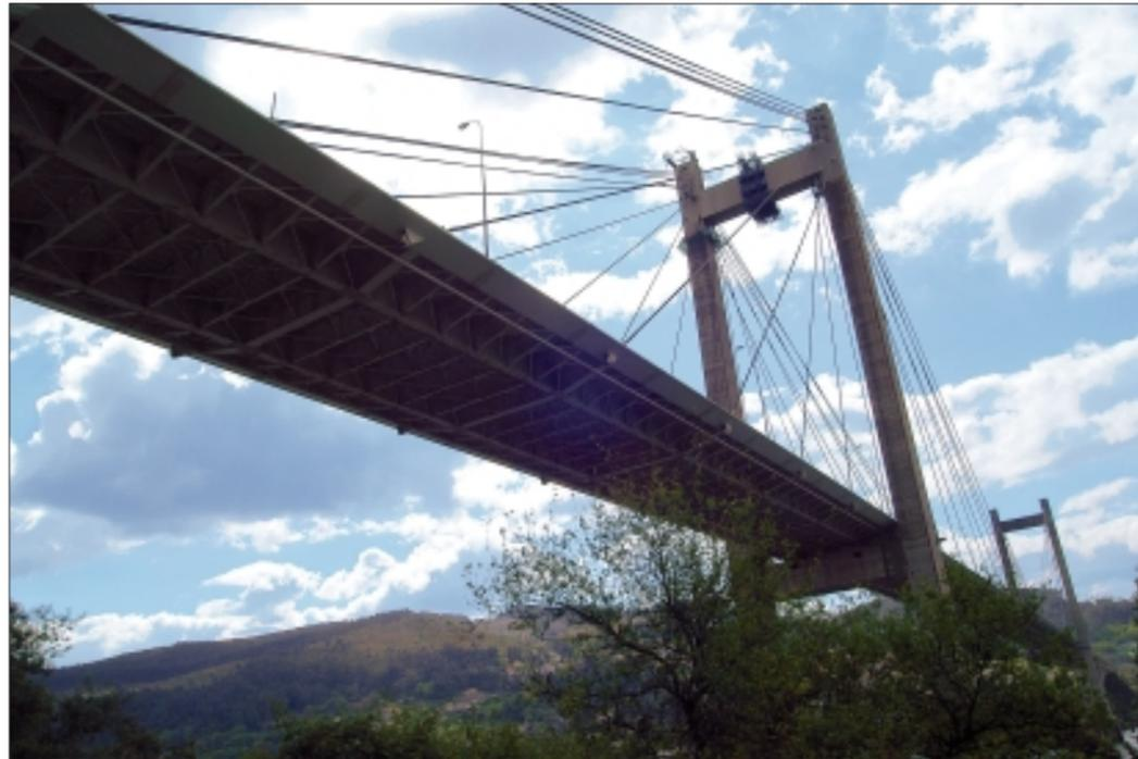
*Izquierda, vista lateral del puente y parte inferior del tablero. Derecha, detalle de los cables anclados en la cabeza de una de las pilas.*
