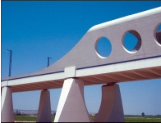
con una sección no homogénea longitudinalmente, tiene un comportamiento claramente tridimensional que hace imprescindible la utilización de técnicas de elementos finitos. Este comportamiento especial lo provoca la presencia de aligeramientos circulares en las almas así como las costillas superiores discontinuas”.
