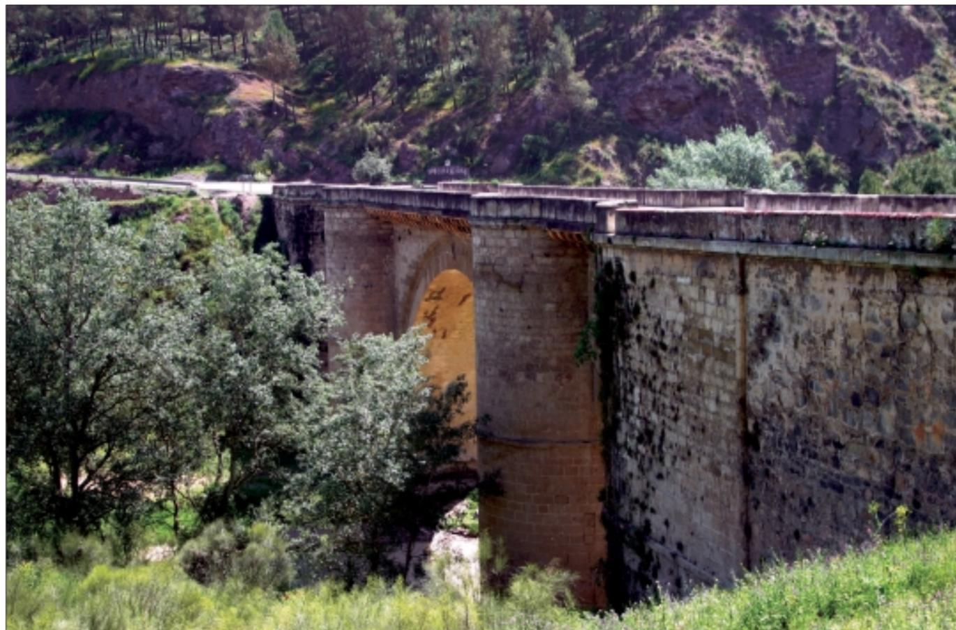
es el original, de 33 metros de luz, tiene una esbeltez de 1/15 y su pila central tiene 1/2,4. Estas medidas no eran fáciles de conseguir porque los puentes de esta época se tenían que adaptar, en general, a la configuración del terreno y apoyaban sus pilas en la base natural de mayor consistencia que éste ofrecía.
