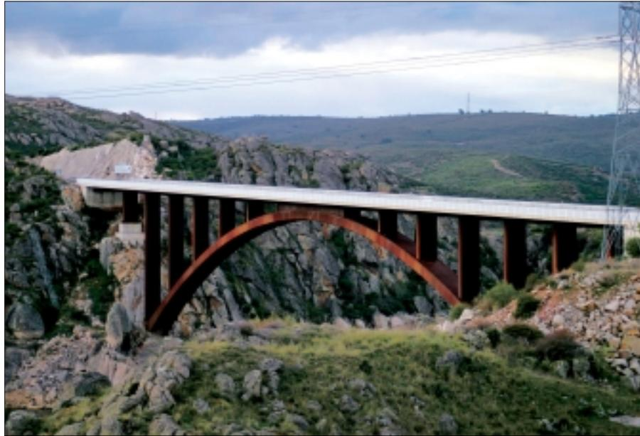
y para evitarlas se proyectó un pretensado de la estructura actuando sobre las diagonales y sobre los gatos de la clave”.
