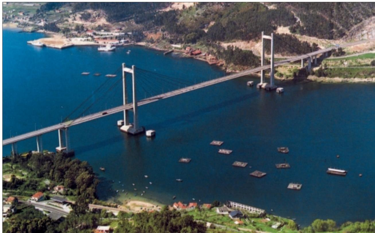
dos vigas cuya sección es una doble T, separadas entre sí a la distancia de 10'10 metros y 5'05 metros de las vigas de borde. El alma de las vigas tiene una altura de 2'20 metros. Las cuatro vigas están conectadas transversalmente cada 21'06 metros en el punto de anclaje de los cables, mediante diagramas de sección en doble T, lo que obliga a una colaboración conjunta de las mismas.
