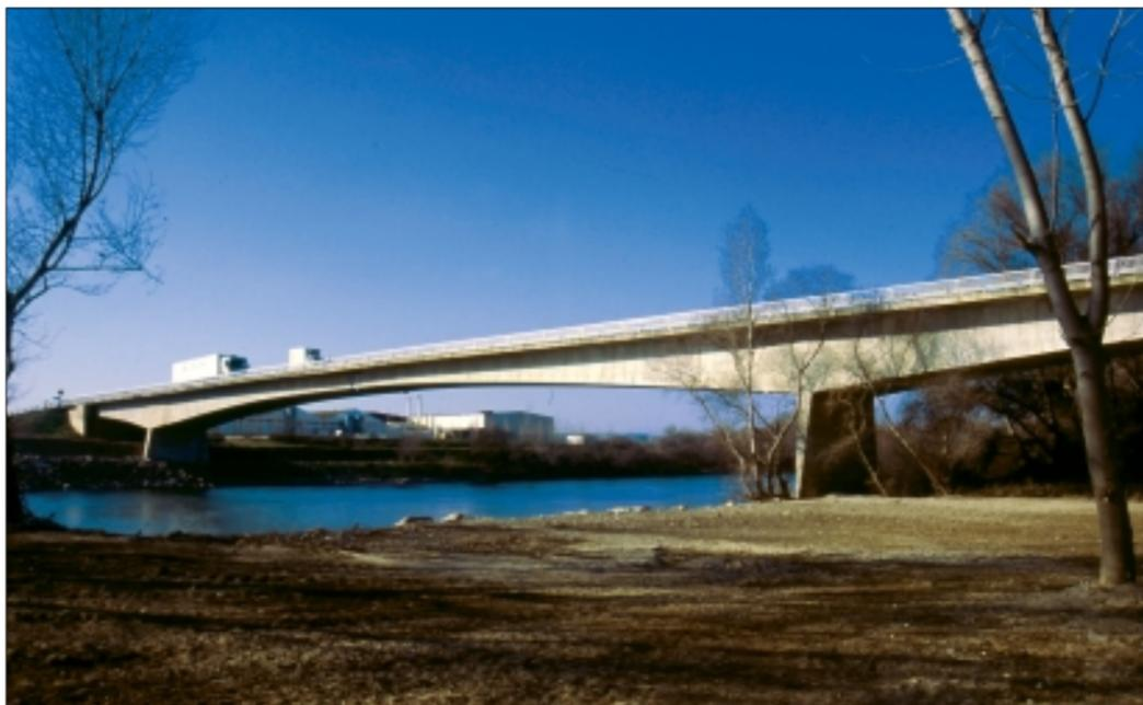
augurando en nuestro país la técnica de los voladizos mediante dovelas prefabricadas. En 1960 ganó un concurso internacional para construir en Cuba un puente por medio de este sistema y en 1962 lo experimentó en el puente de Almodóvar del Río sobre el Guadalquivir, en Córdoba. Se trata de un puente con una luz principal de 70 metros en el que probó con éxito la nueva técnica, con dovelas inferiores a 10 toneladas de peso y medios de montaje y colocación muy ligeros.
