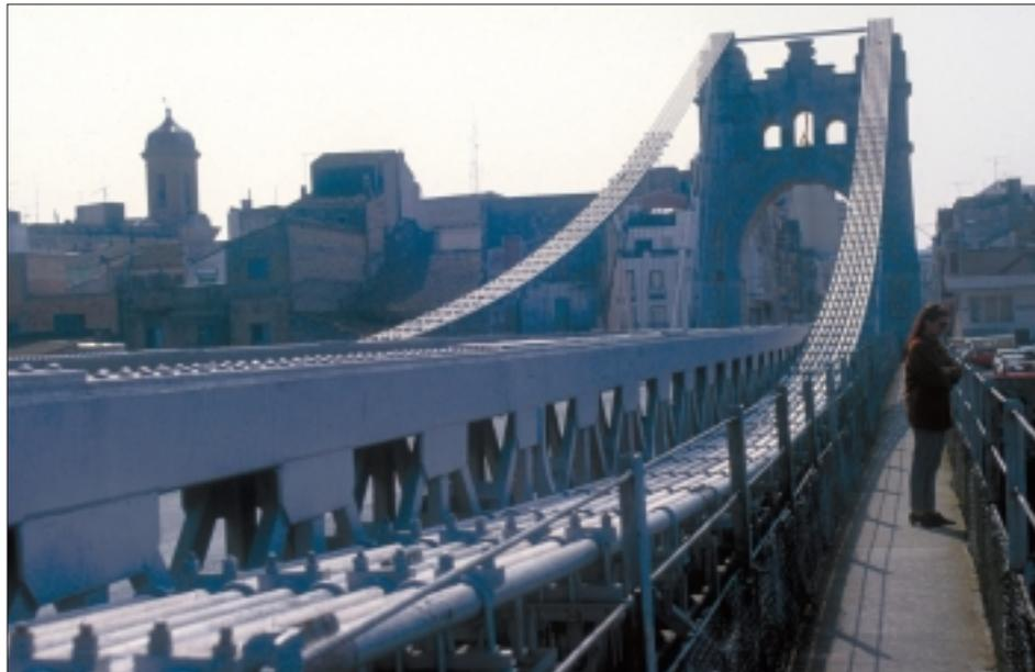
*Cables suspensores y la pasarela instalada en la posguerra, con Amposta recortada al fondo.*
