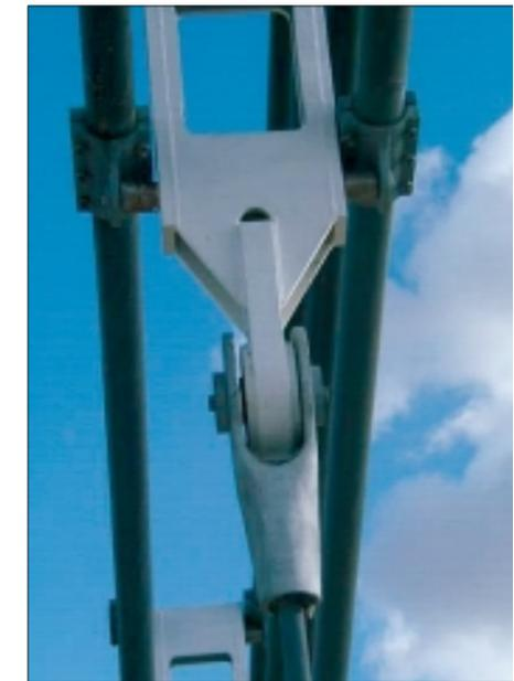
con un tubo tipo barra perforada de 273 mm. de diámetro exterior y 35 mm. de espesor, que se suelda al alma y platabanda superior de las vigas transversales del tablero.
