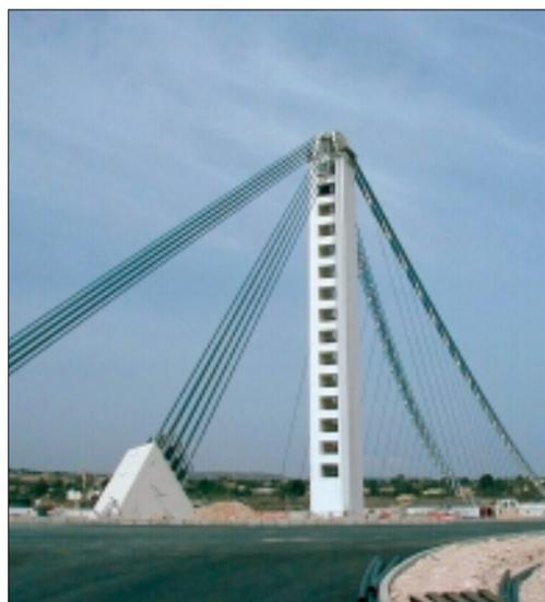
*Contrapeso y anclaje de los cables y pila principal. En la página opuesta, tendido del tablero y anclajes.*
