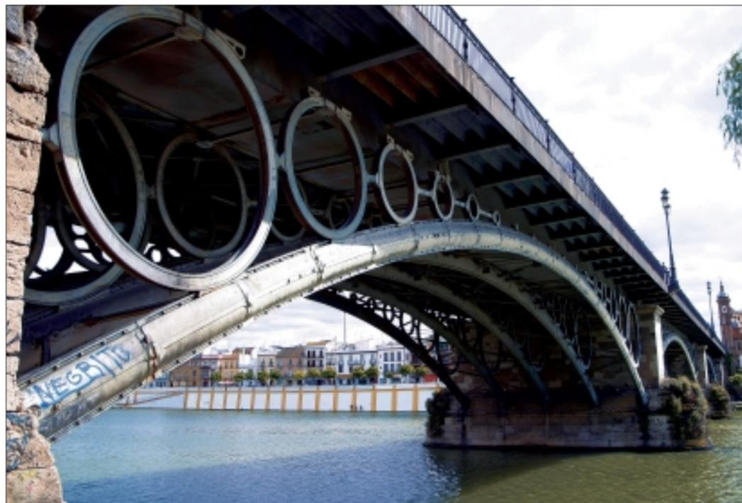
Los arcos de fundición y los aros circulares de hierro que apoyan el tablero siguen la tipología del puente del Carroussel, en París.
