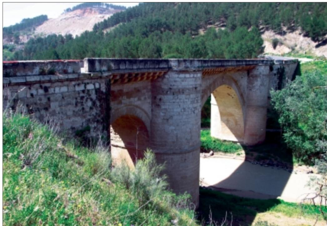
*El puente se sustenta sobre dos fuertes estribos apoyados en las laderas y dos pilas centrales que separan el arco central.*
