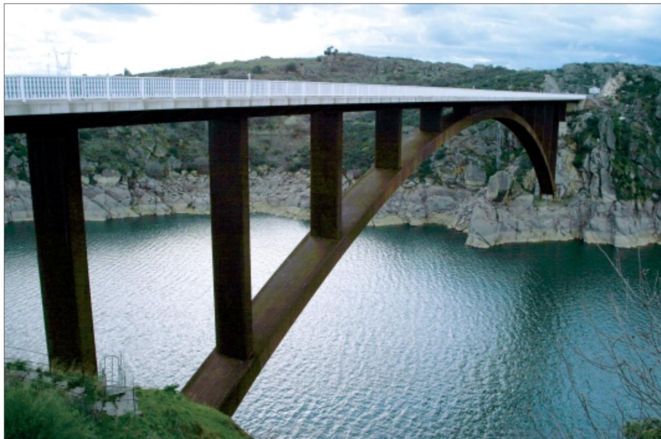
dos extremos de 11.50 metros. Los dos primeros vanos de cada lado se apoyan sobre pilas metálicas en el terreno y el resto lo hace sobre un arco mixto hiempotrado que salva el embalse. Todo el acero de la estructura es del tipo patinable y autoprotectible contra la corrosión”.
