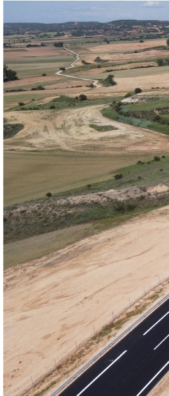
10 m. En el trazado se han dispuesto cuatro pasos de mediana. El paquete de firme implantado ha sido diseñado para una categoría de tráfico T1. Está formado por una explanada E3, base de suelo cemento de 20 cm y una capa de 20 cm de espesor de mezclas bituminosas en caliente. La IMD (Intensi-
