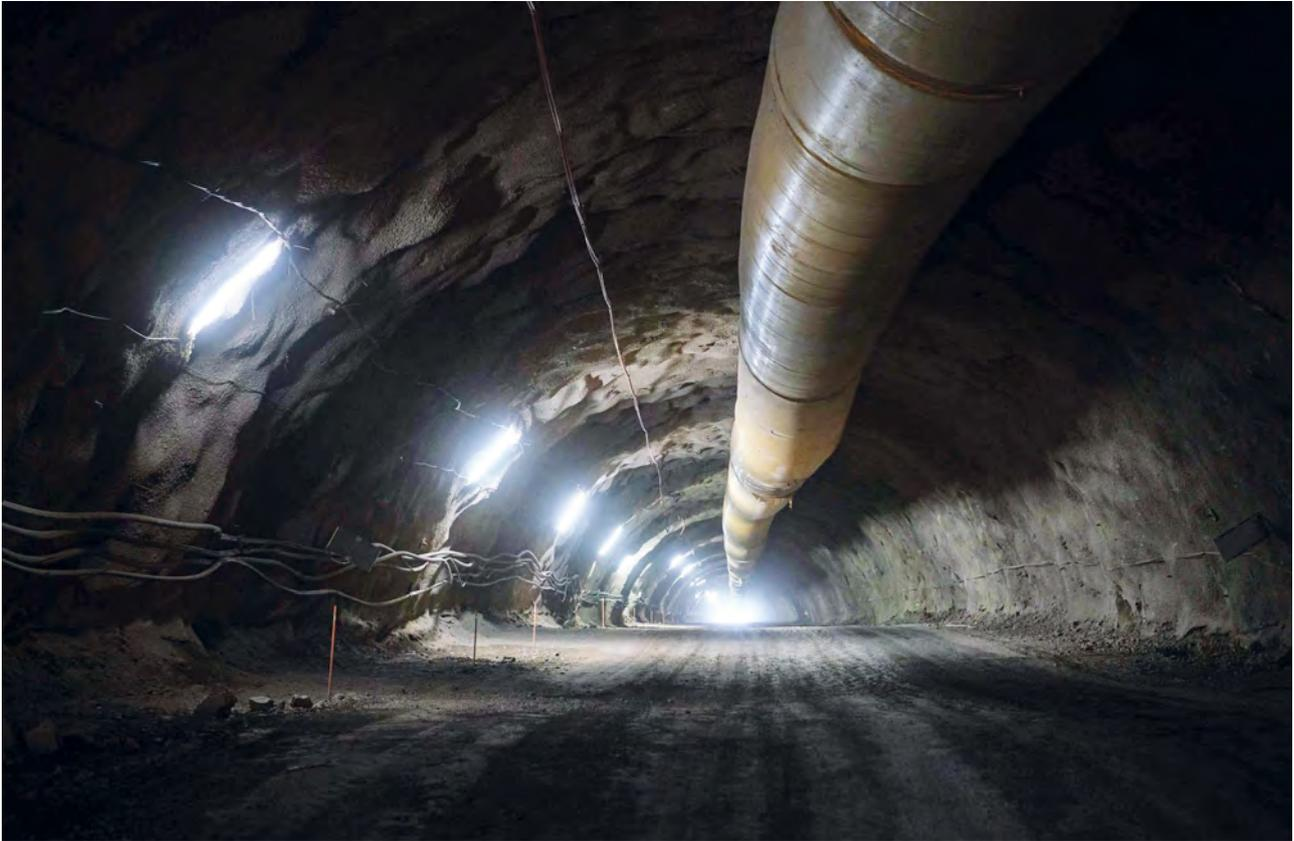
La sección del túnel tiene una anchura de 11,50 m y un gálbo de 5,30 m.
