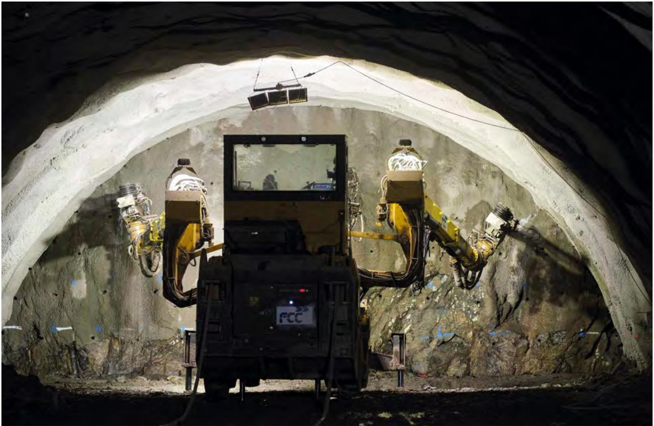
Uno de los *jumbos* ataca el frente de excavación.
