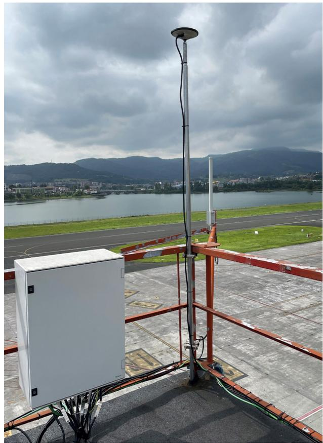
Antenas GNSS de estación RECNET de ENAIRE.
