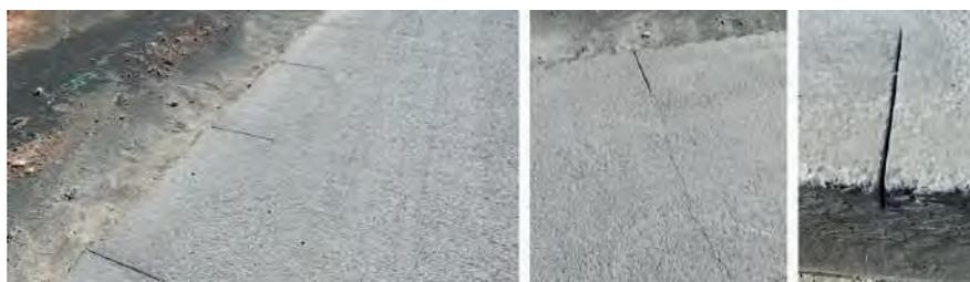
Figura 26. Cortes para inducción del patrón de fisuración
