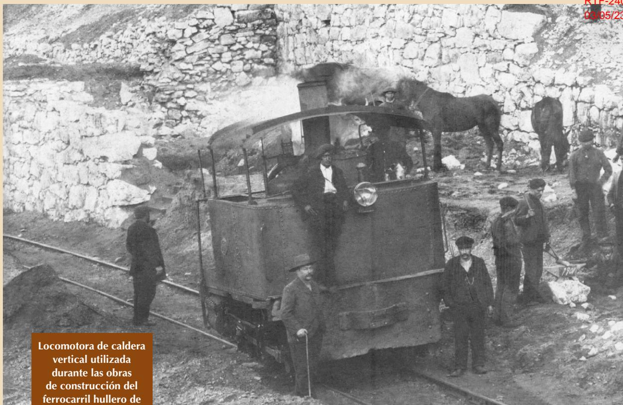
**Locomotora de caldera vertical utilizada durante las obras de construcción del ferrocarril hullero de La Robla a Valmaseda.**
