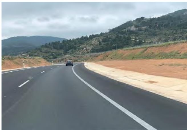
Figura 4. Apartadero exterior sobre cuneta de seguridad
