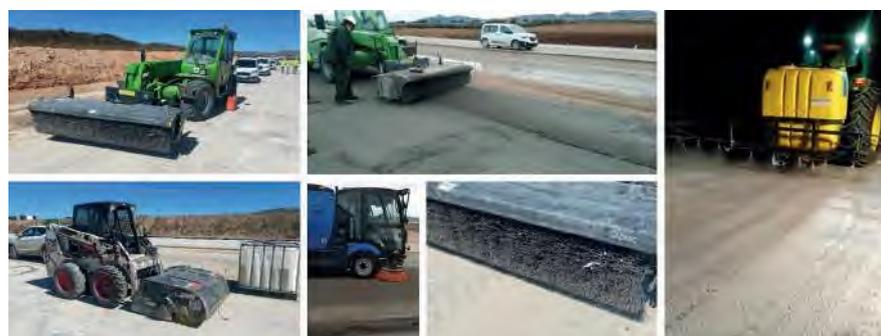
Figura 23. Operaciones de barrido, limpieza y curado final
