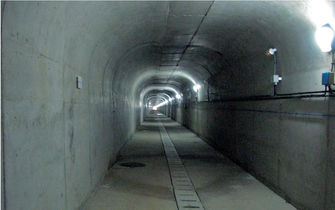
Galería longitudinal de inspección, con terna de bases para elongómetro y registro de pozo de arcilla en primer término
